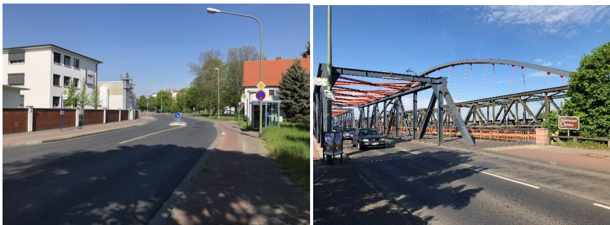
Abbildung 33: Gemeinsame Wegeführung für den Fuß- und Radverkehr im Kinzigheimer Weg (links), Wegeverbindung Steinheimer Mainbrücke mit beidseitigem Fahrrad- und Fußgängerweg (rechts) (Bildquelle: ProjektStadt 2019)
